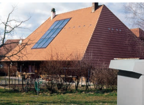
Solaranlagen und Wärmepumpen
